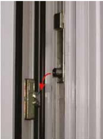
**Bild 4-5:** Einfacher Verschluss (sog. Rollzapfen)
