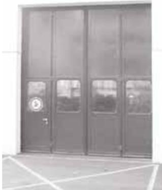
**Bild 5-4:** Falttor mit Verglasung und Schlupftür
