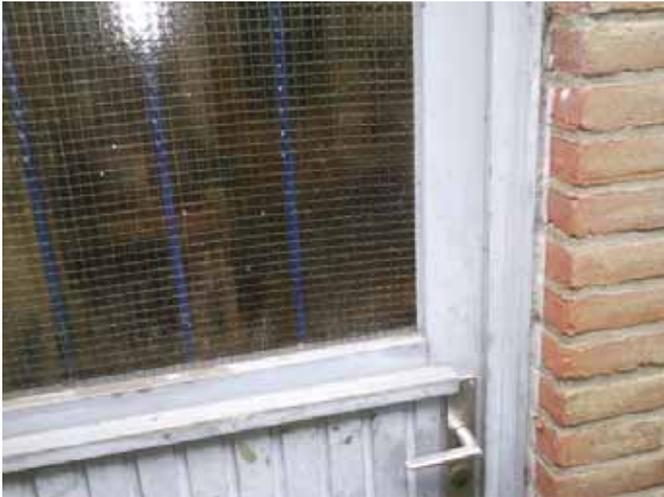
**Bild 4-6:** Kellertür mit Drahtglaseinsatz
