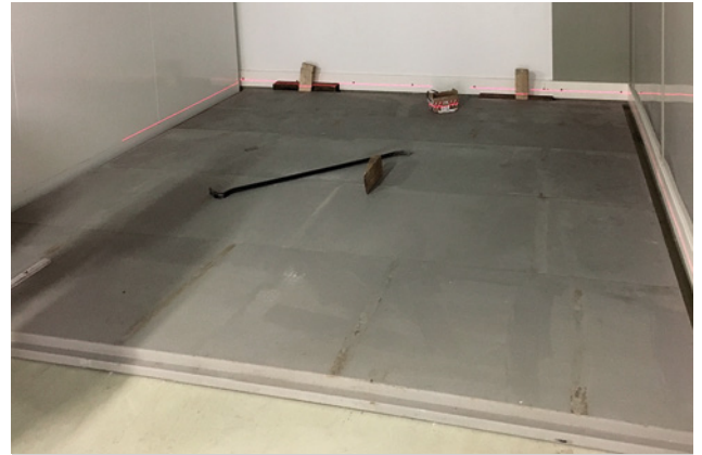
Verlegung des Modulraum-Bodens
