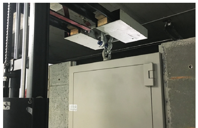
Setzen der Wertschutzraumtür
