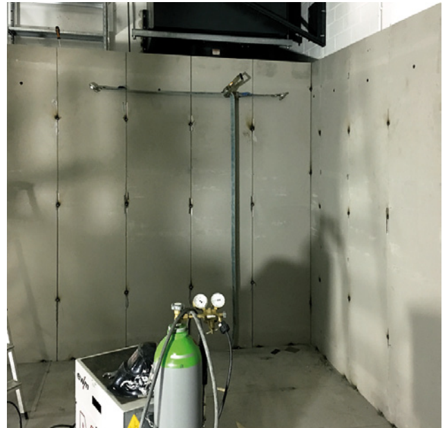
Aufbau Wandelemente (Verschweißung)
