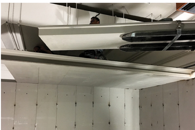
Einbau Deckenelemente
