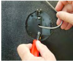
7. Führen Sie das Schlosskabel durch das Loch in der Mitte der Montageplatte und befestigen Sie dann die Platte mithilfe der silbernen Schrauben (8-32) bzw. den eingefärbten M4-Schrauben an der Tresortür. Die Auswahl der Schrauben richtet sich nach den vorbereiteten Löchern in der Tresortür.
